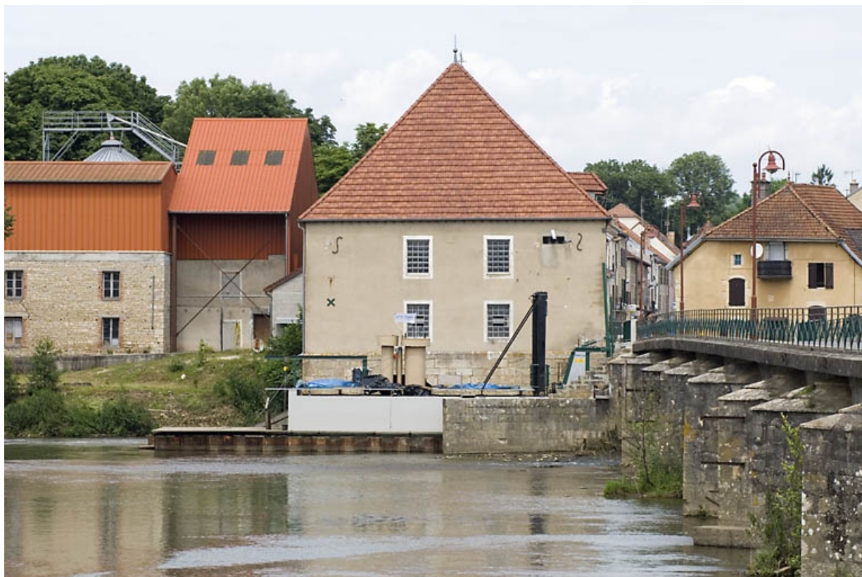
Vue depuis le sud.
