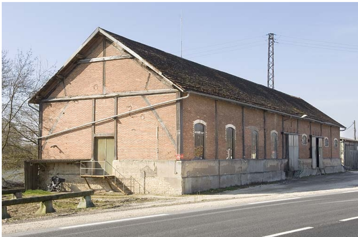
Magasin industriel depuis le nord-est.
