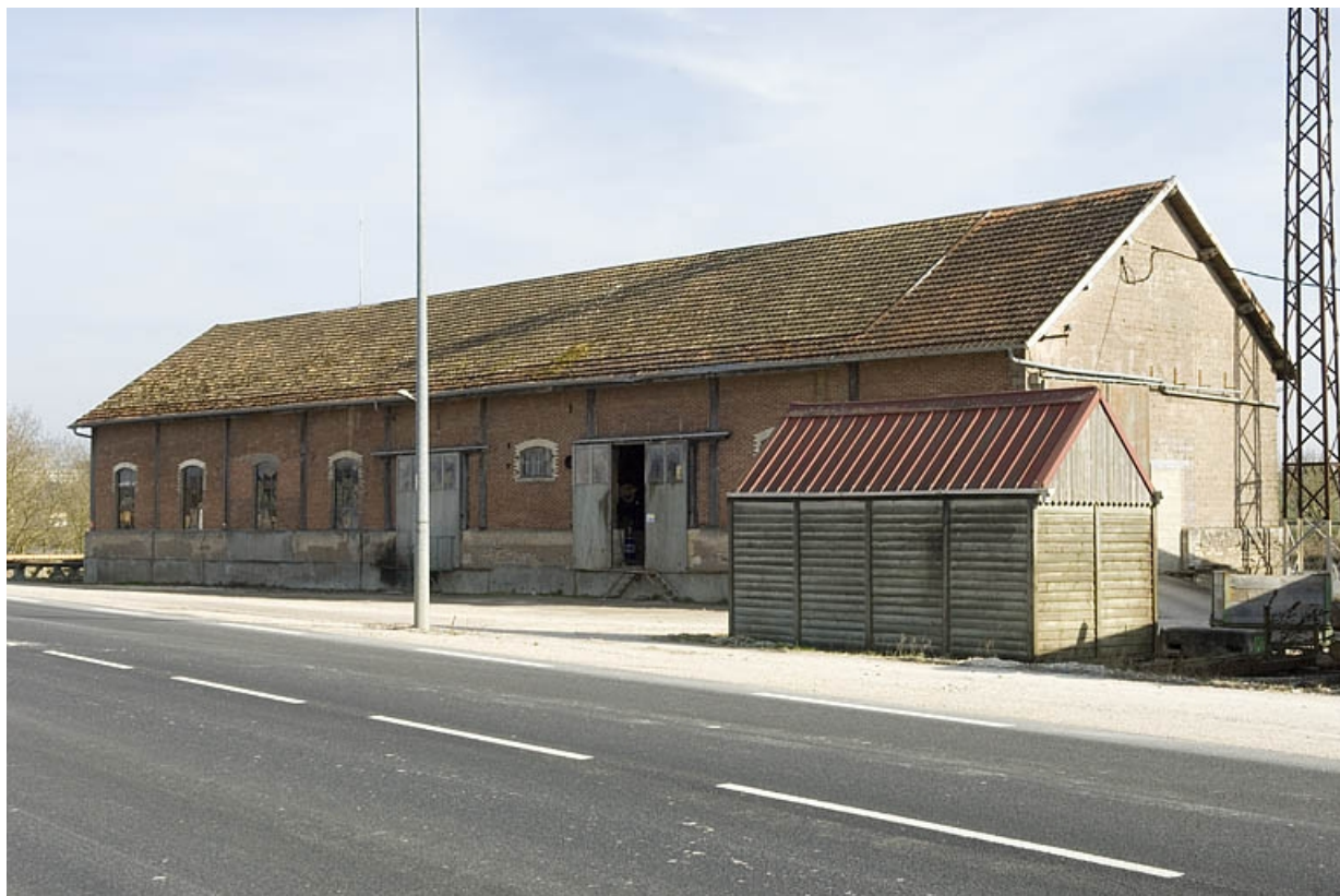
Magasin industriel depuis le nord-ouest.
