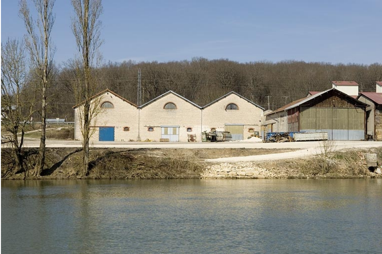
Atelier de fabrication depuis le sud-est.
