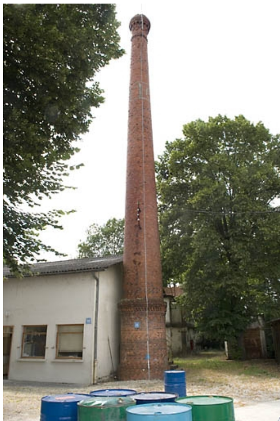
Vue d'ensemble de la cheminée.
