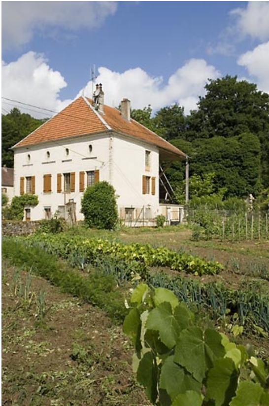
Logement patronal vu depuis le nord-est.
