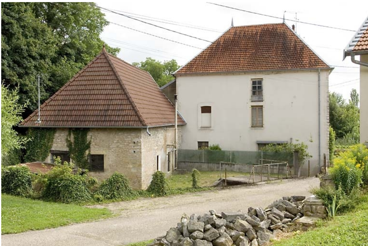
Vue d'ensemble depuis le sud.
