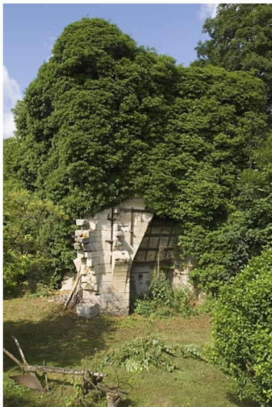
Etat du massif du haut fourneau.
