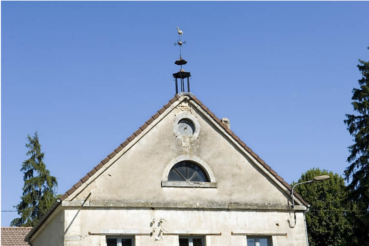
Fronton du bâtiment d'eau.
