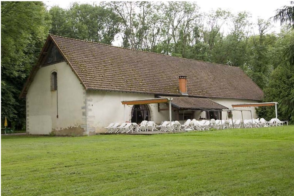
Ancienne halle à charbon depuis le sud.
