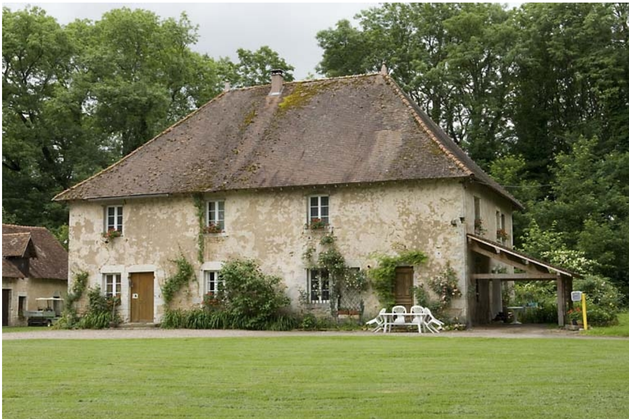
Logement patronal vu de trois quarts droite.
