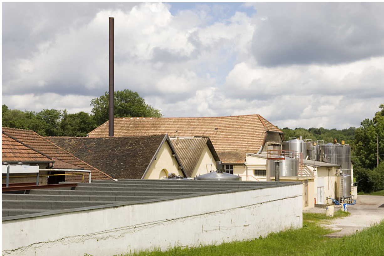
Vue arrière des bâtiments industriels.
