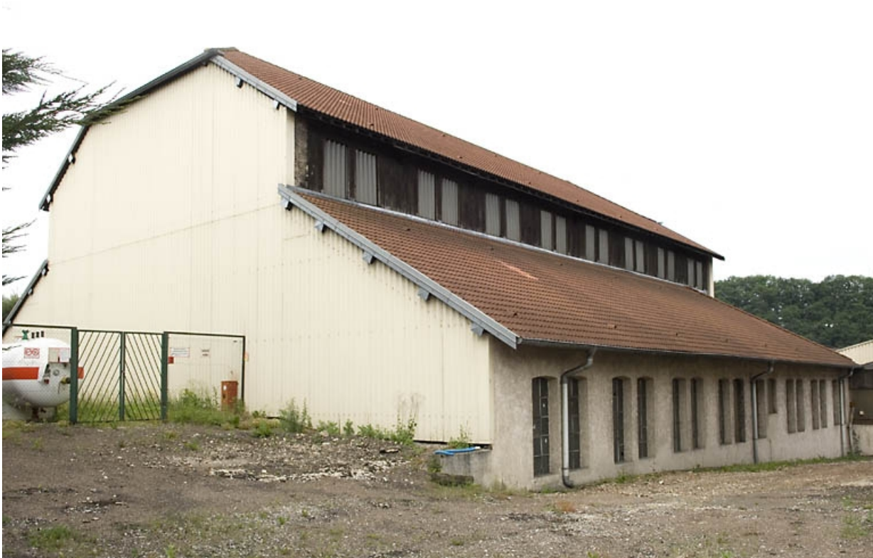
Atelier de fonderie depuis le nord-est.
