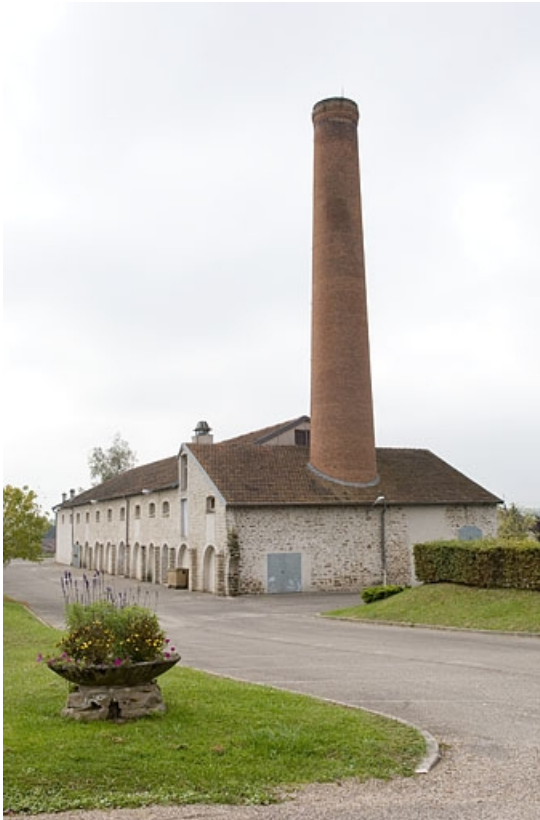
Vue depuis l'est (cadrage vertical).
