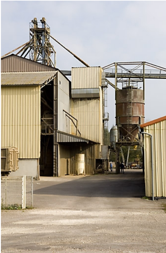
Silos et système de transport des céréales.
