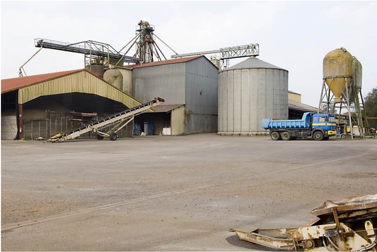
Silos et entrepôts industriels depuis l'arrière.
