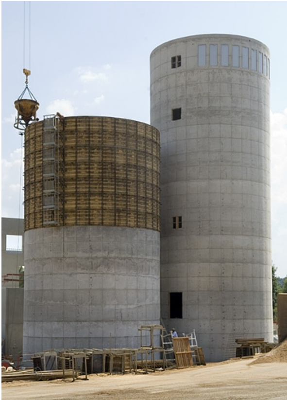
Chaufferie et silos à sciure en construction.
