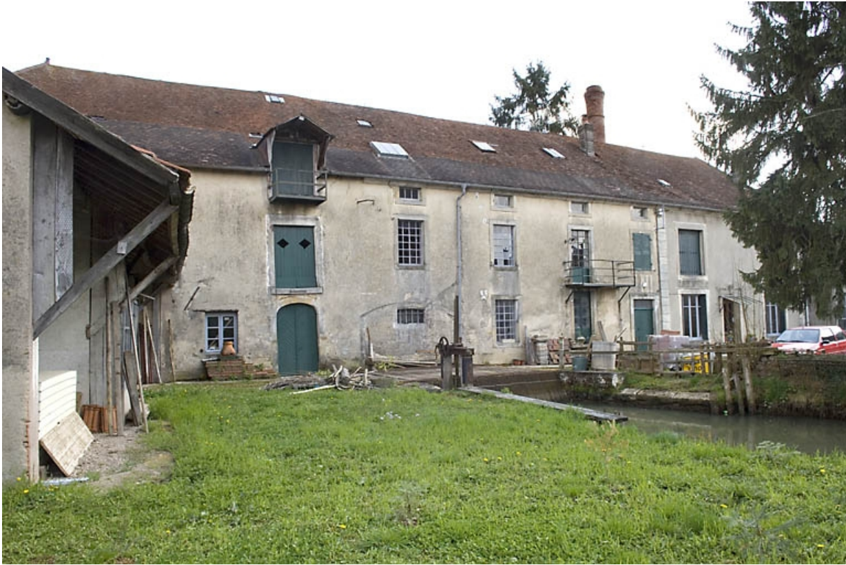
Façade antérieure depuis le nord-ouest.
