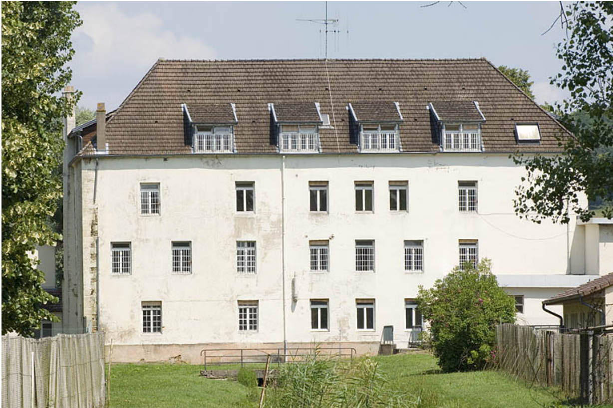
Façade postérieure depuis l'aval du bief.
