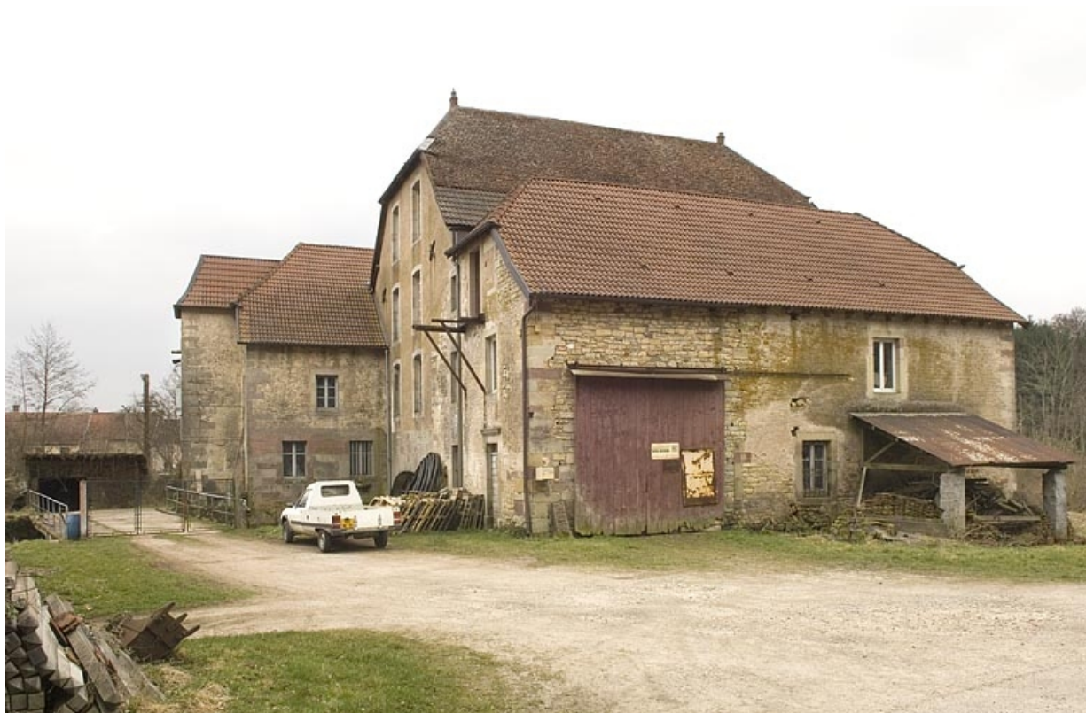
Vue depuis l'ouest.
