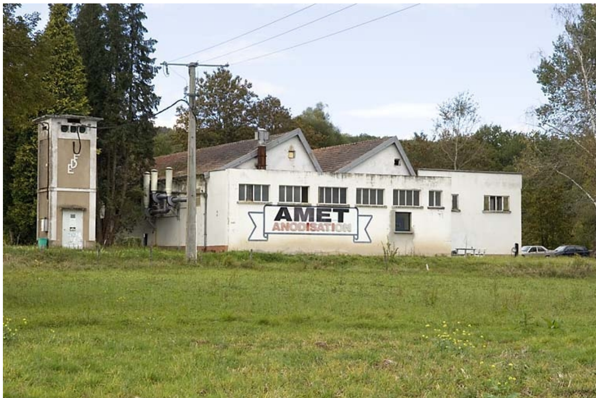
Vue depuis le sud.
