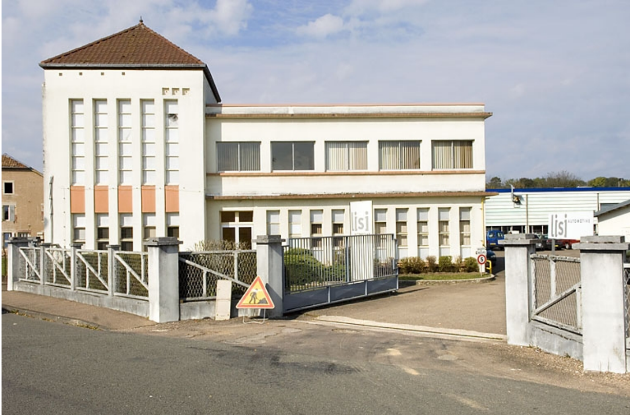
Façade antérieure. Transformateur et bureau.
