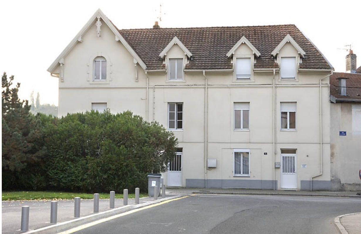
Logement ouvrier (?). Vue de face.
