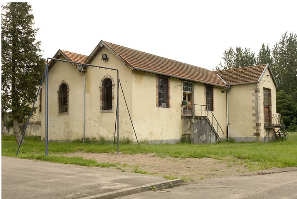
Centrale hydroélectrique. Vue de trois quarts.
