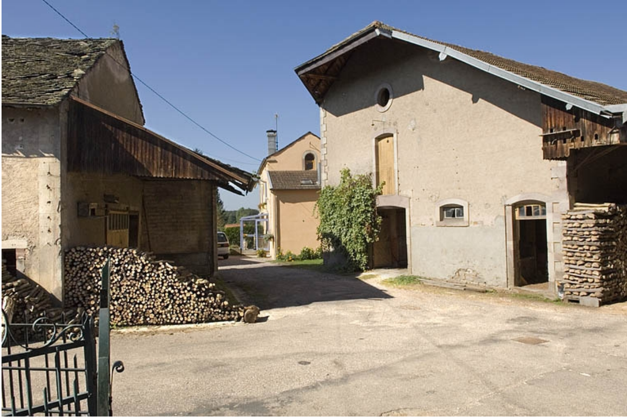
Bâtiments industriels. Vue depuis le logement patronal.
