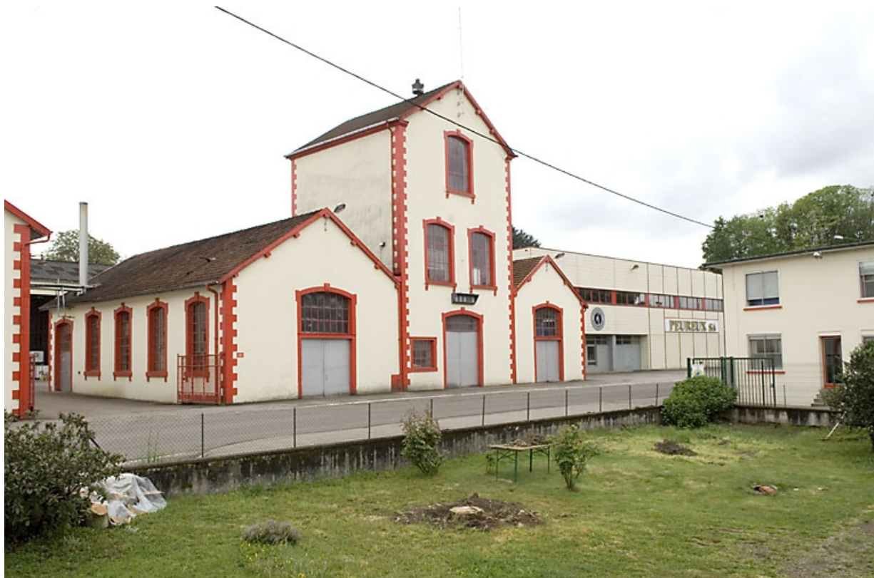
Bâtiments industriels. Vue de trois quarts gauche.
