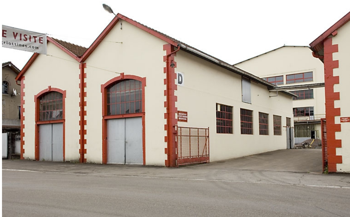
Atelier de réparation. Vue de trois quarts.
