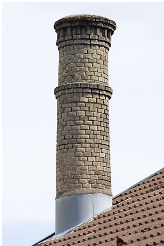
Détail de la souche de la cheminée.
