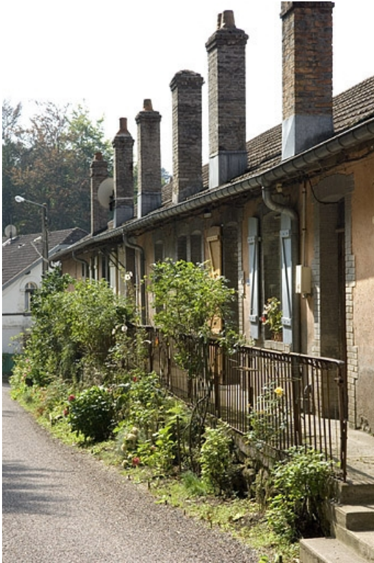
Façade des logements ouvriers route de Plombières.
