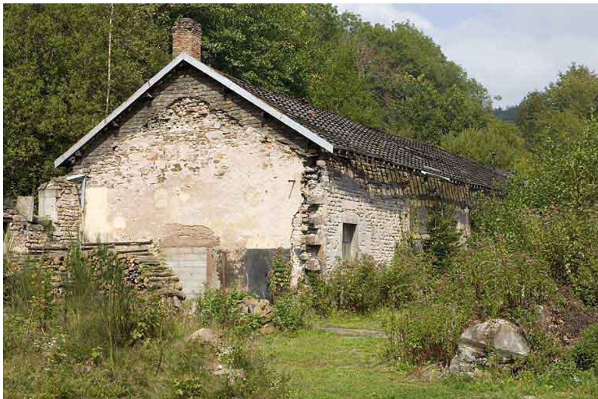
Ancien atelier de fabrication (galvanisation et trempe).
