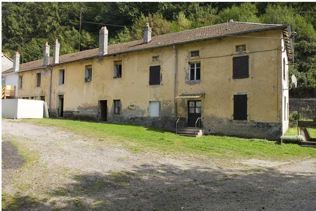
Façade occidentale des logements ouvriers.
