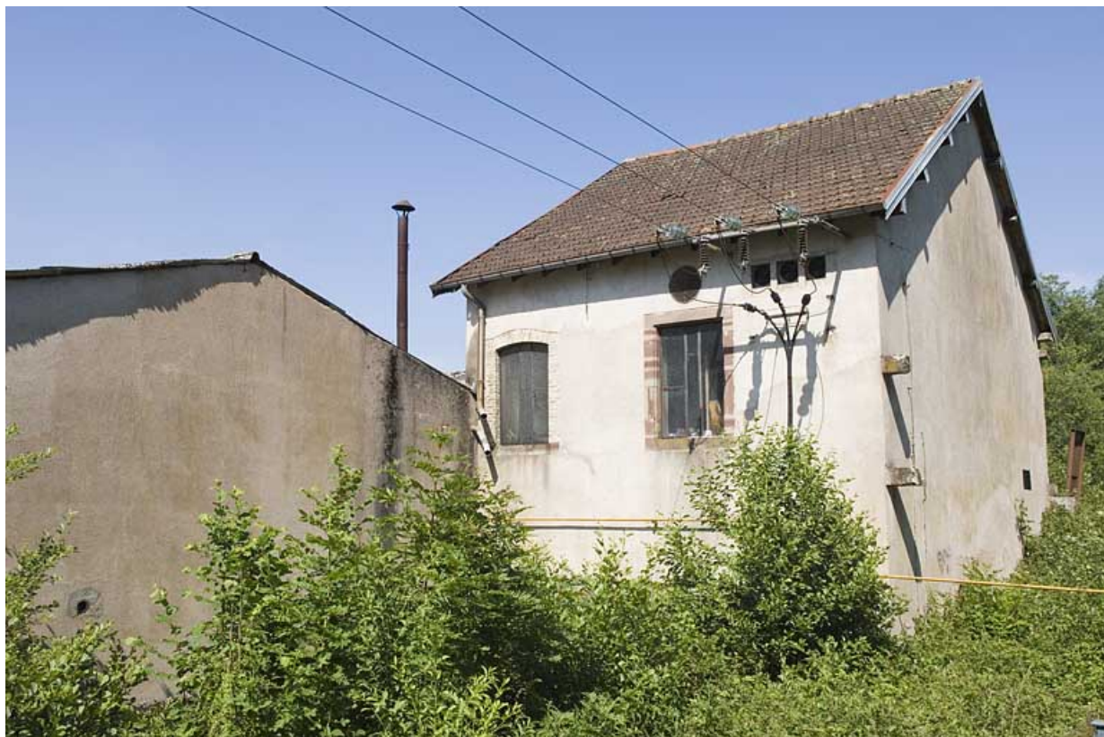
Bâtiment d'eau, actuellement transformateur.
