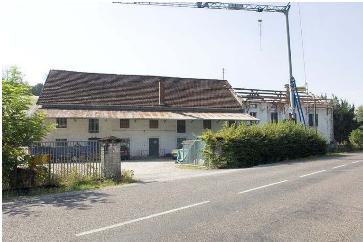
Vue d'ensemble depuis la rue.
