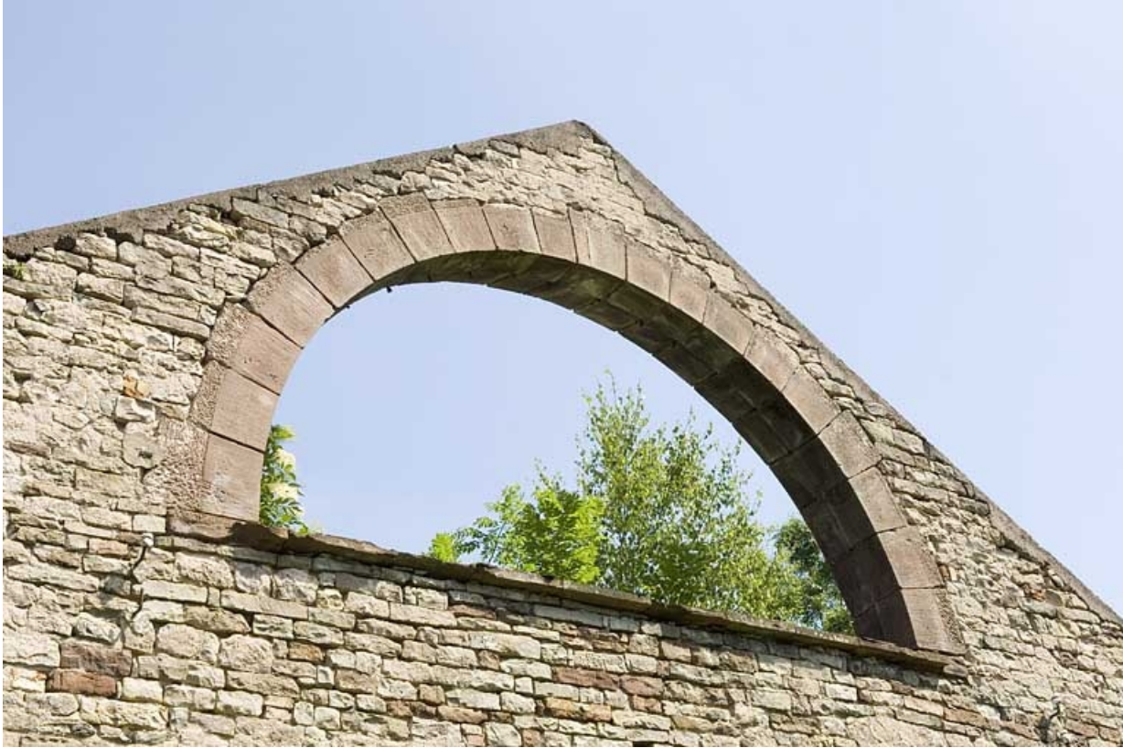
Atelier du laminier. Baie du pignon ouest.
