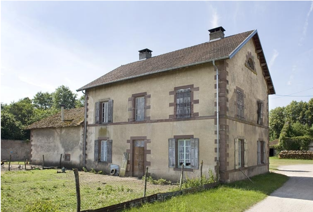
Pavillon est depuis le chemin d'accès.
