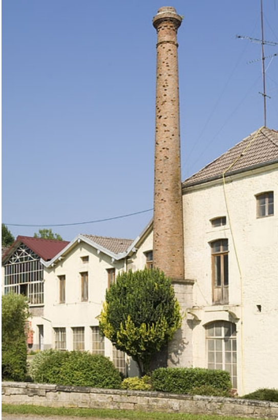
Façade est des ateliers et cheminée.
