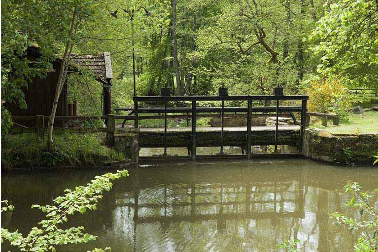
Vannes de décharge sur le bief d'amenée.
