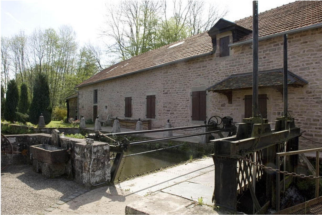
Logement (rive gauche) depuis l'est.
