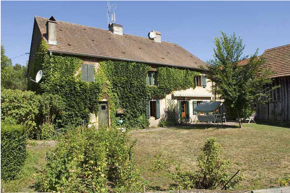
Ancien magasin, actuellement logement. Façade postérieure.
