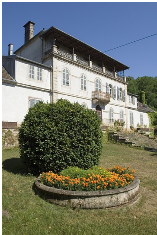
Logement patronal nord. Vue de trois quarts.
