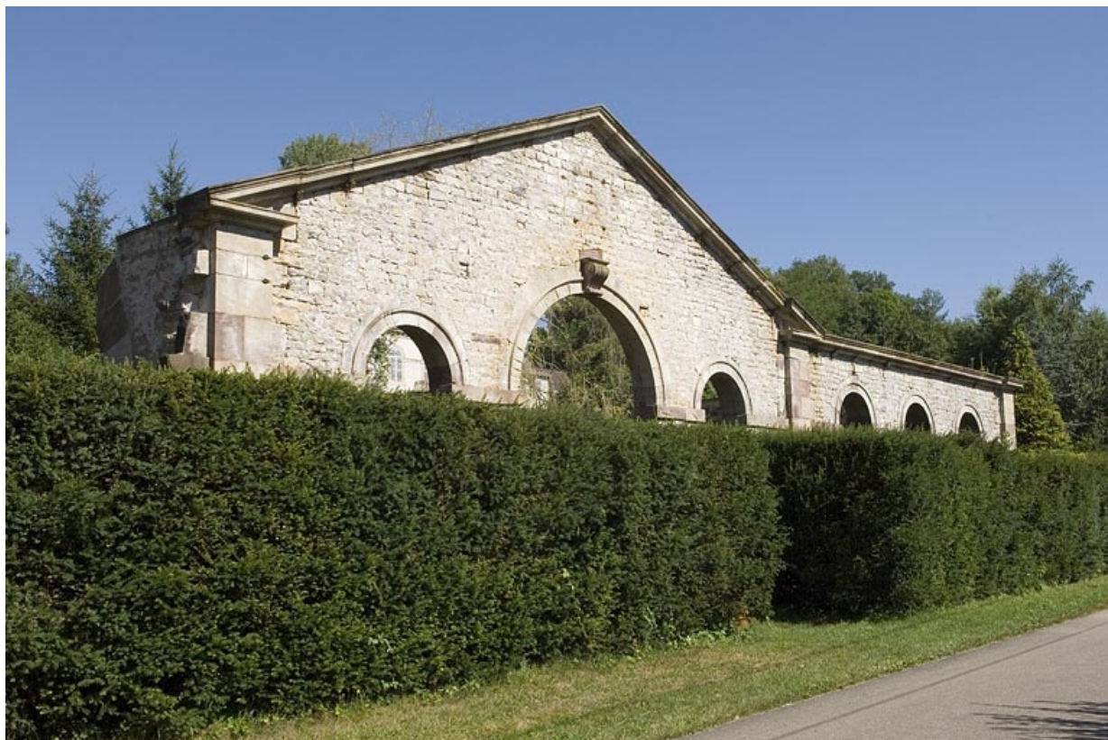
Façade antérieure de l'atelier du haut fourneau.
