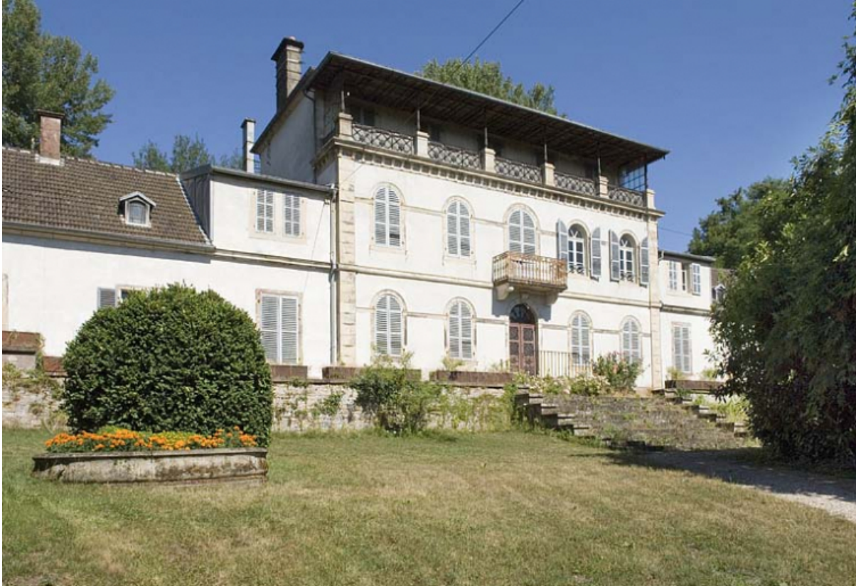
Logement patronal nord. Façade antérieure.
