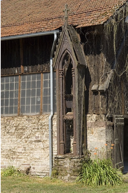
Pinacle en fonte adossé au magasin industriel.
