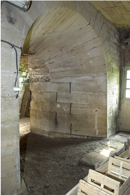
Détail d'une embrasure et de son appareillage.
