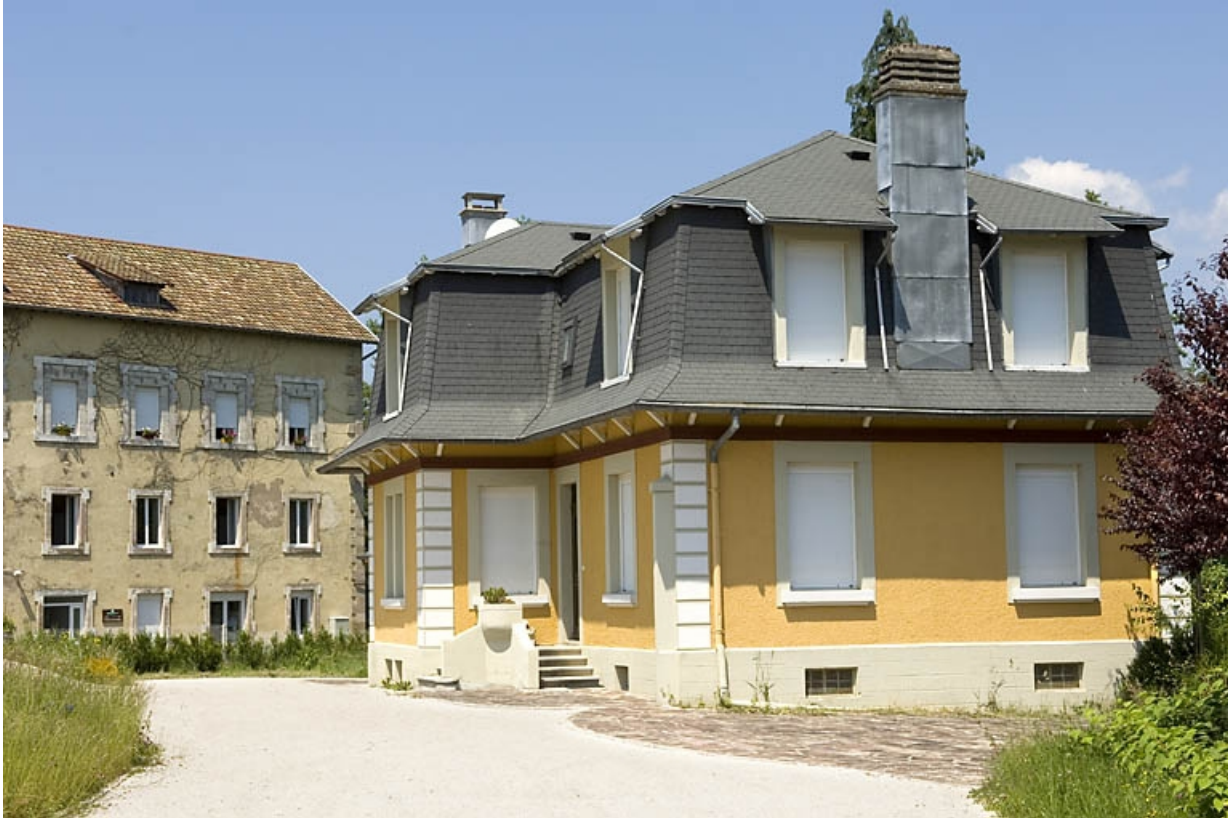
Ancien atelier de fabrication et logement patronal.
