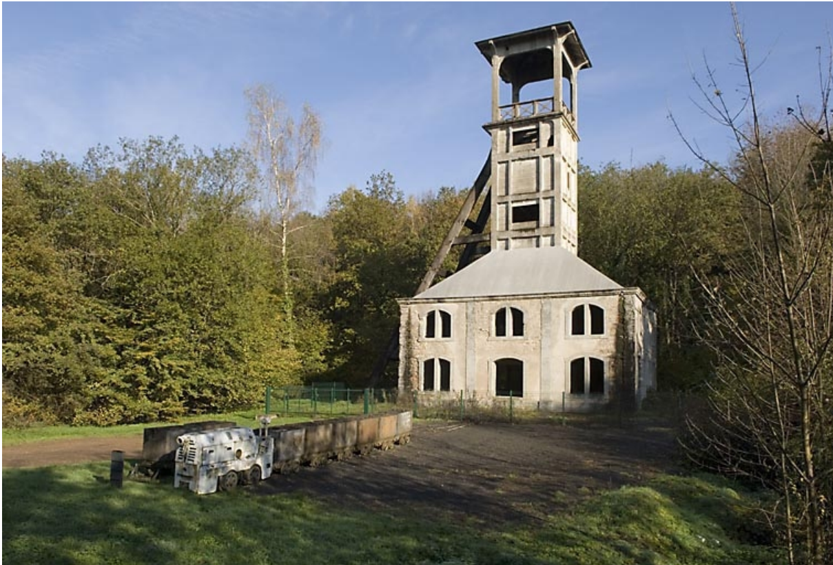
Le chevalement. Vue d'ensemble depuis le sud-ouest.
