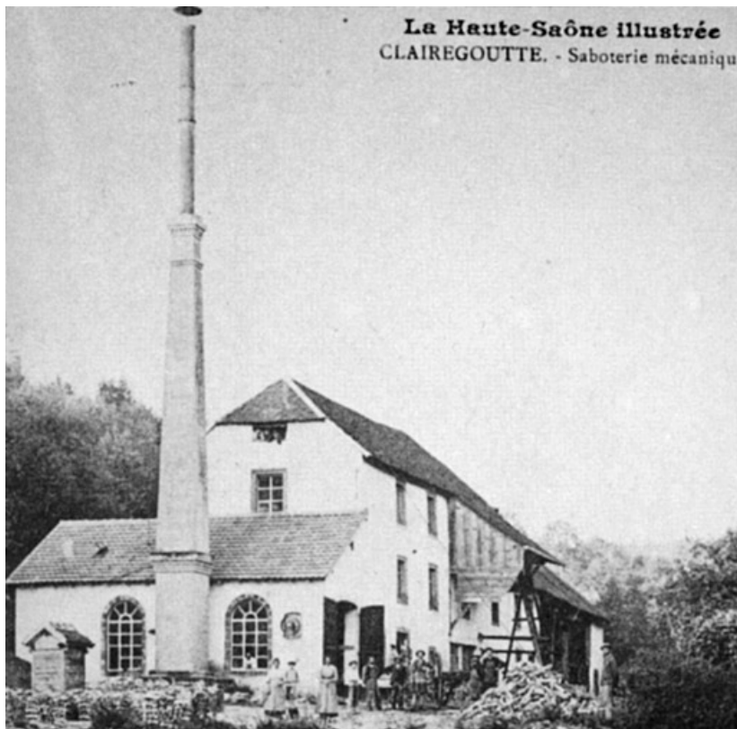
Clairegoutte. - Saboterie mécanique.
