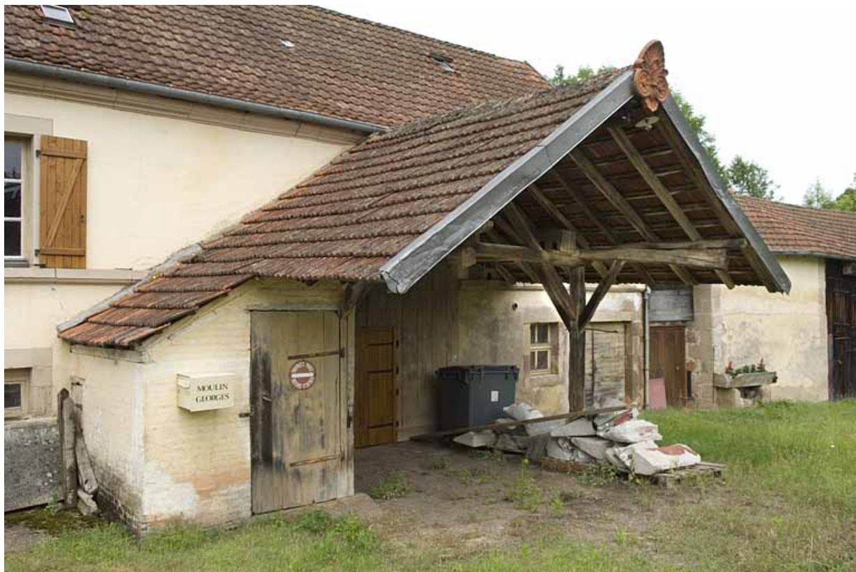
Auvent sur la façade antérieure.
