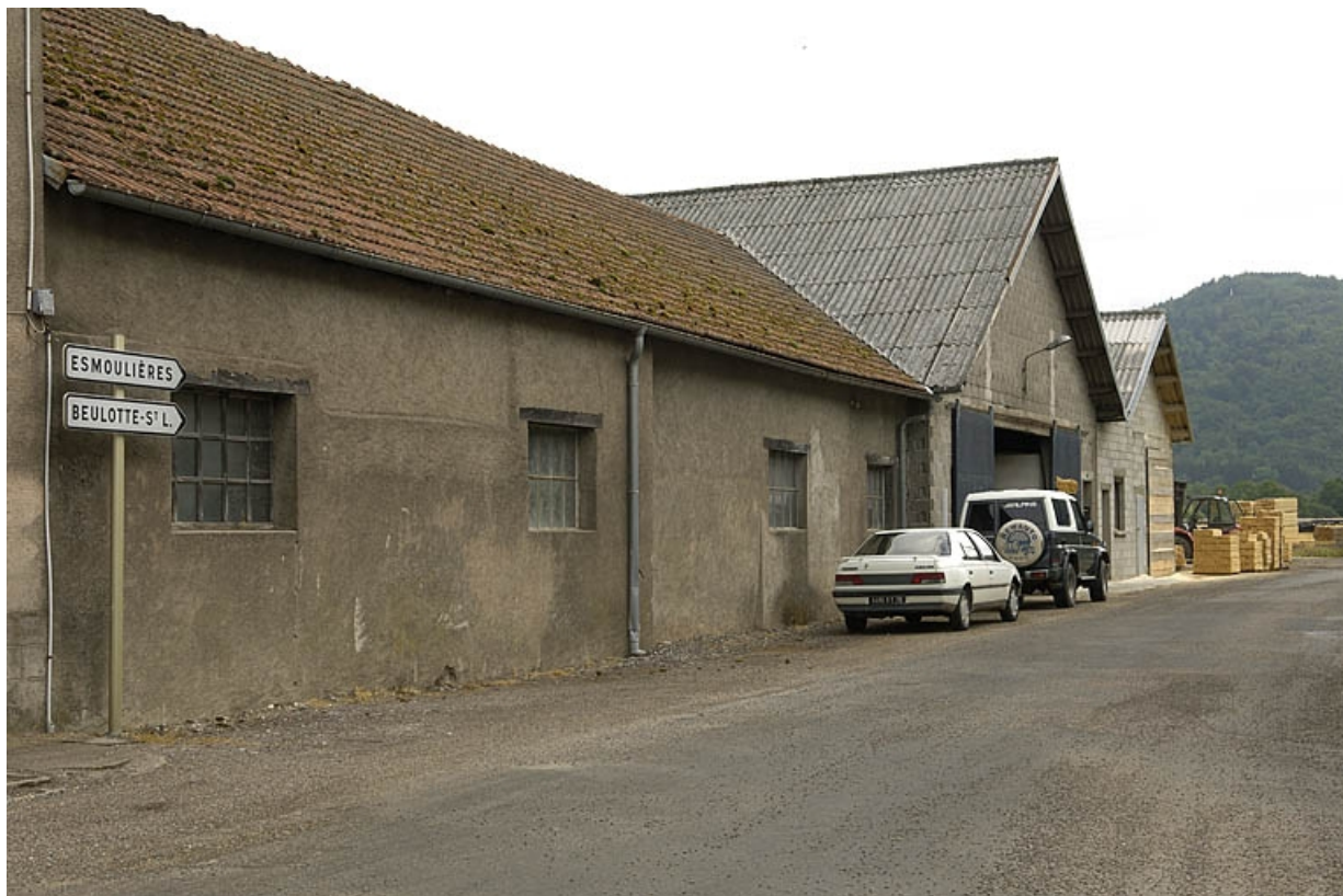
Façade de l'atelier de tournerie.
