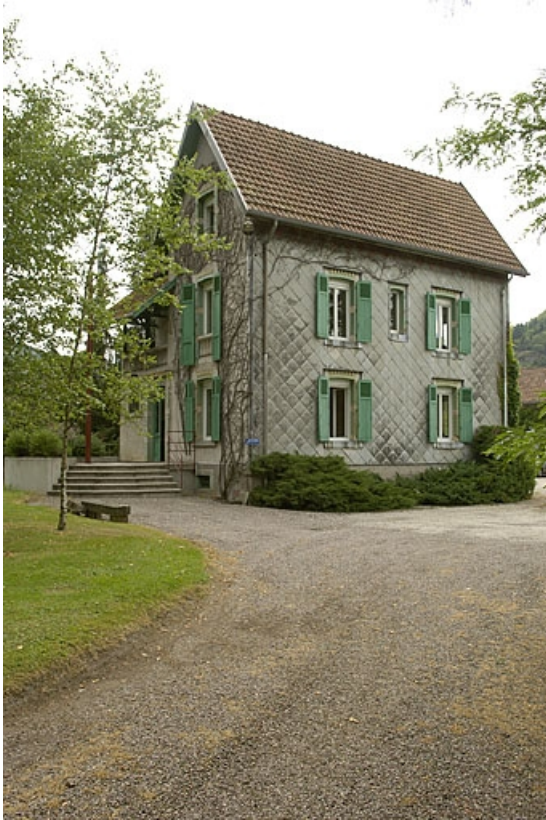
Ancien logement patronal. Vue depuis l'entrée.
