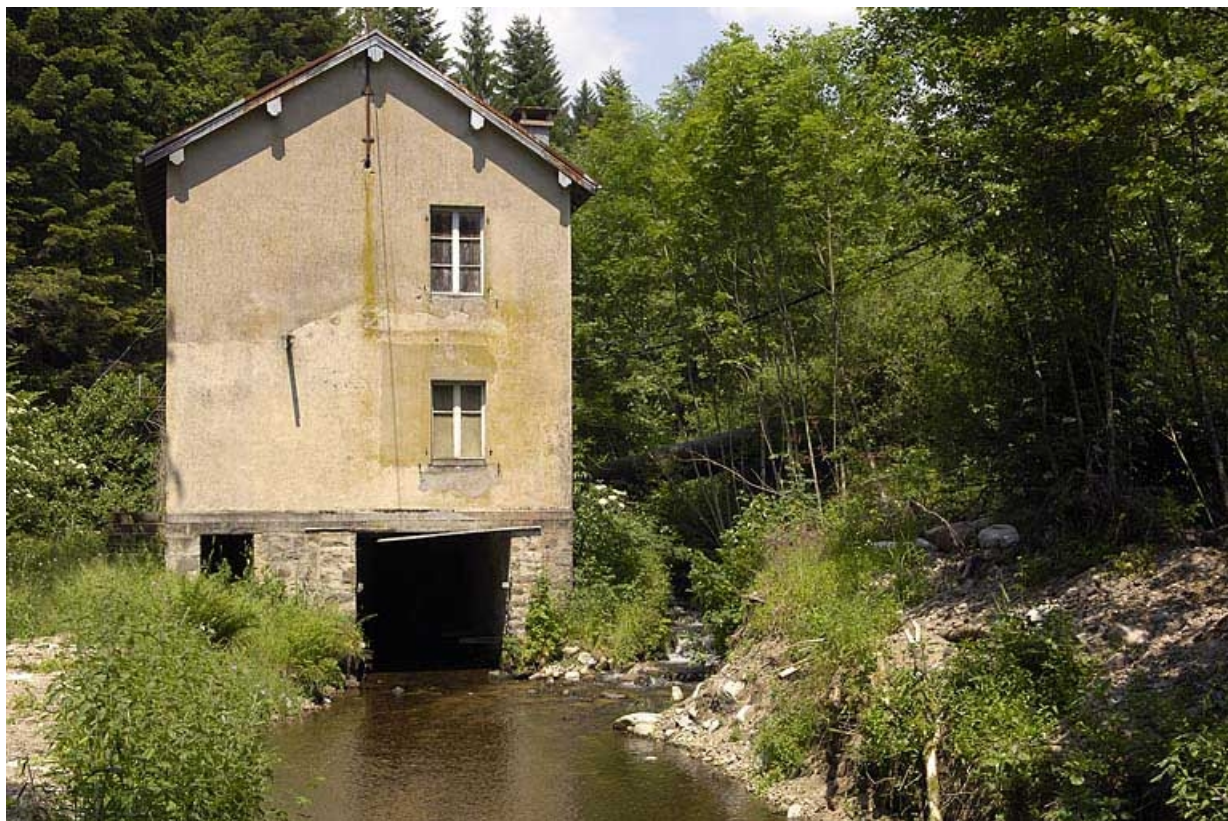
Vue depuis l'aval.
