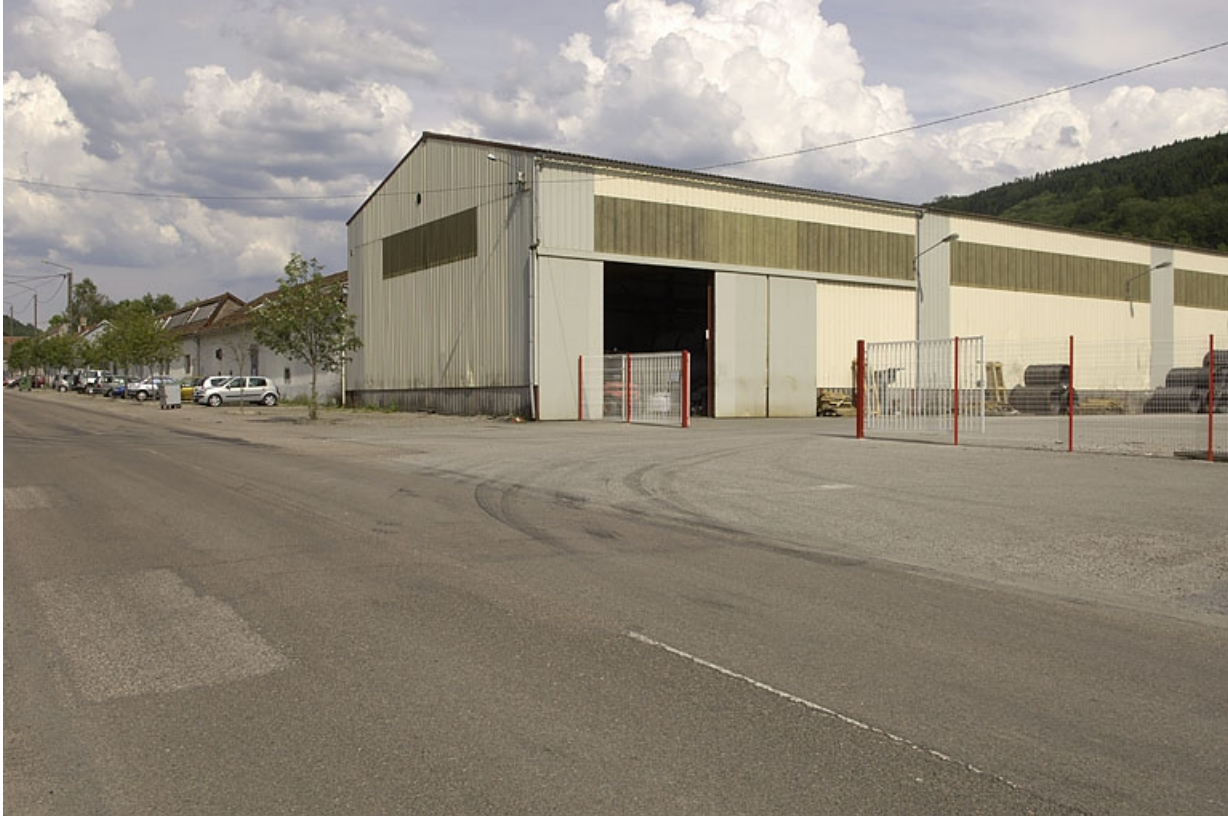
Atelier de fabrication (filature) et extension ouest.
