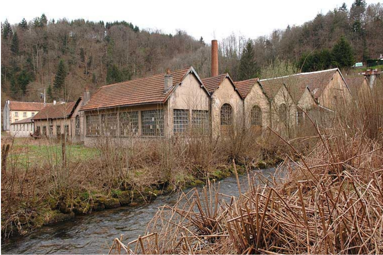
Vue des ateliers depuis le sud.
