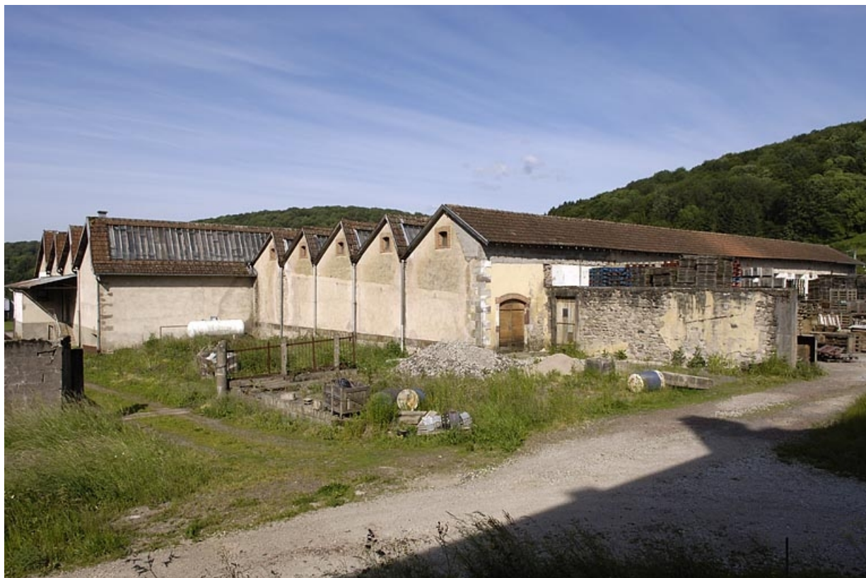
Les ateliers de filature vus depuis l'est.
