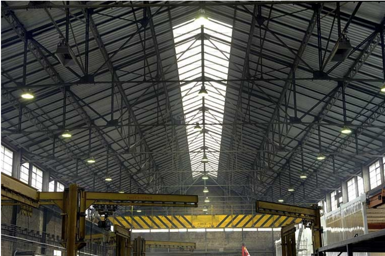
Atelier de fabrication. Charpente et couverture métallique.
