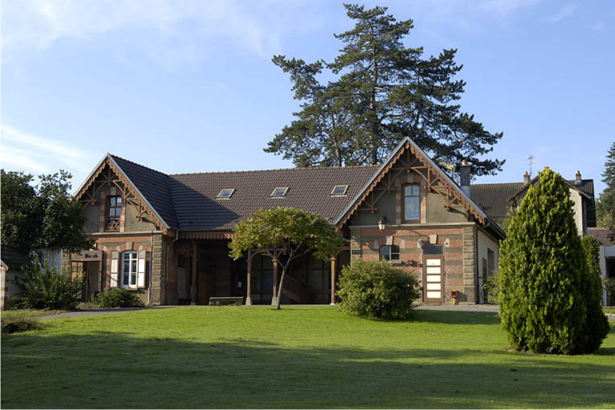
Vue d'ensemble de l'ancienne écurie (?).
