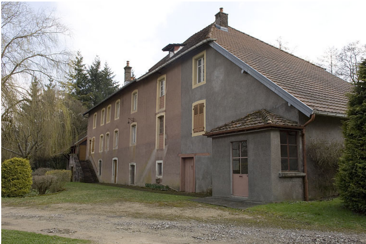
Façade antérieure depuis l'ouest.
