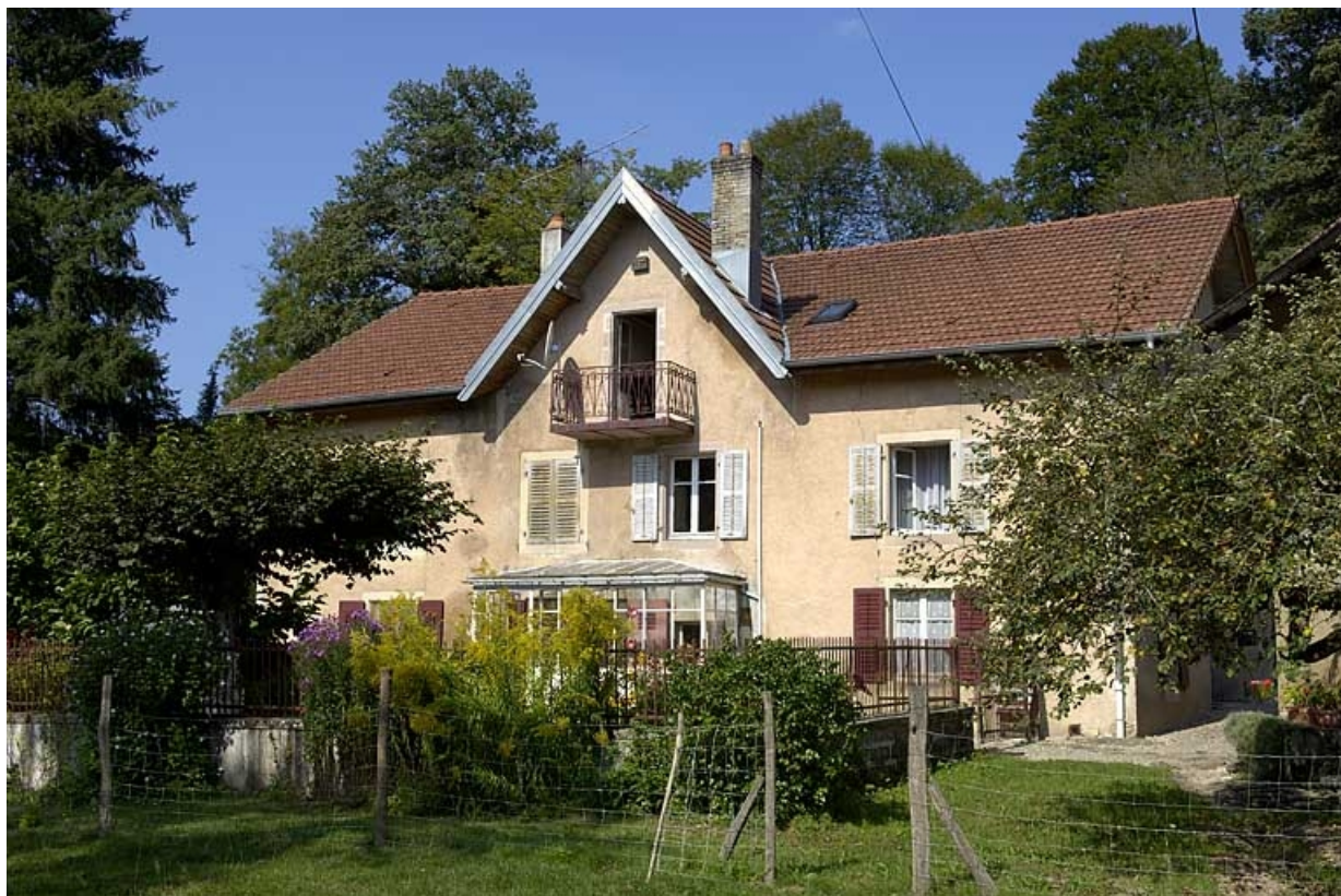
Façade sud du moulin.
