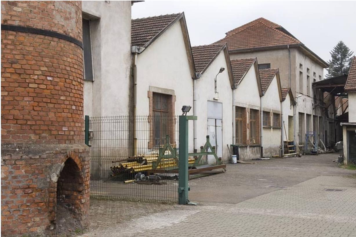
Pignons des sheds de l'atelier.
