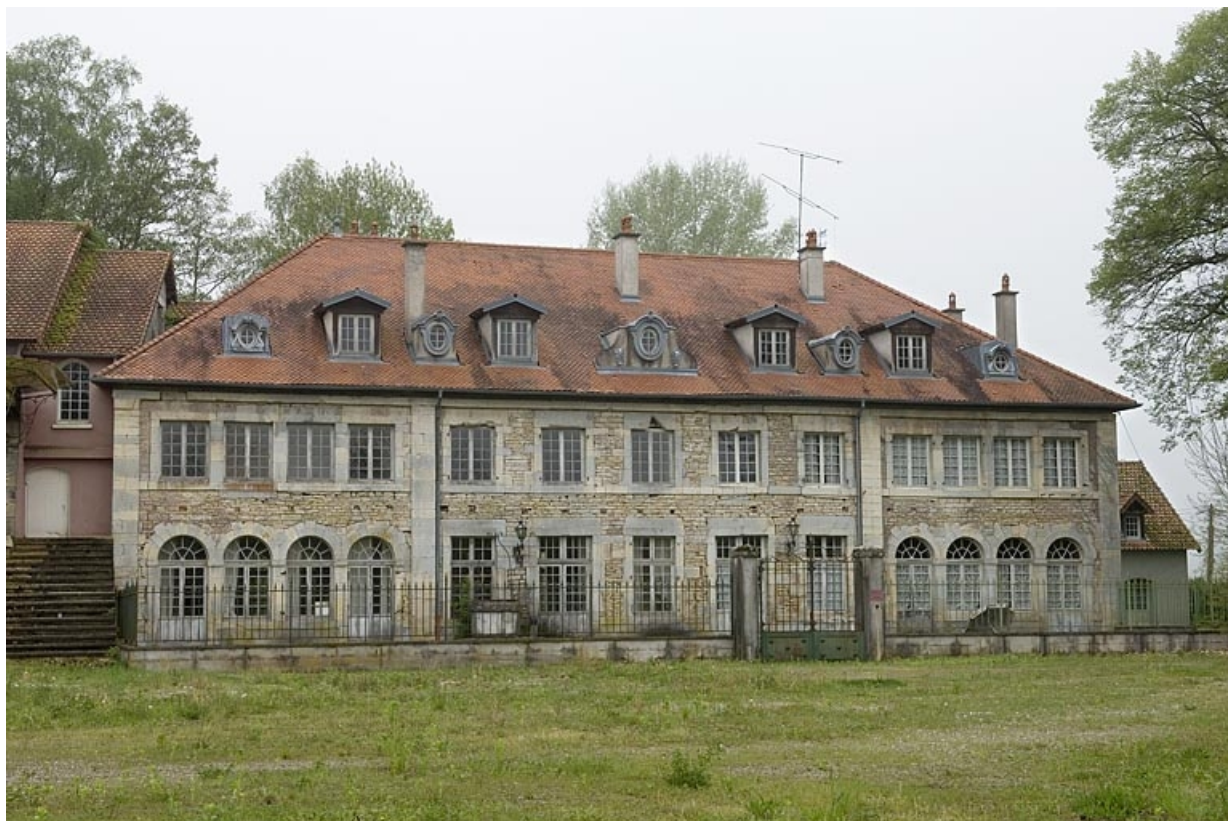
Logement patronal. Façade antérieure.
