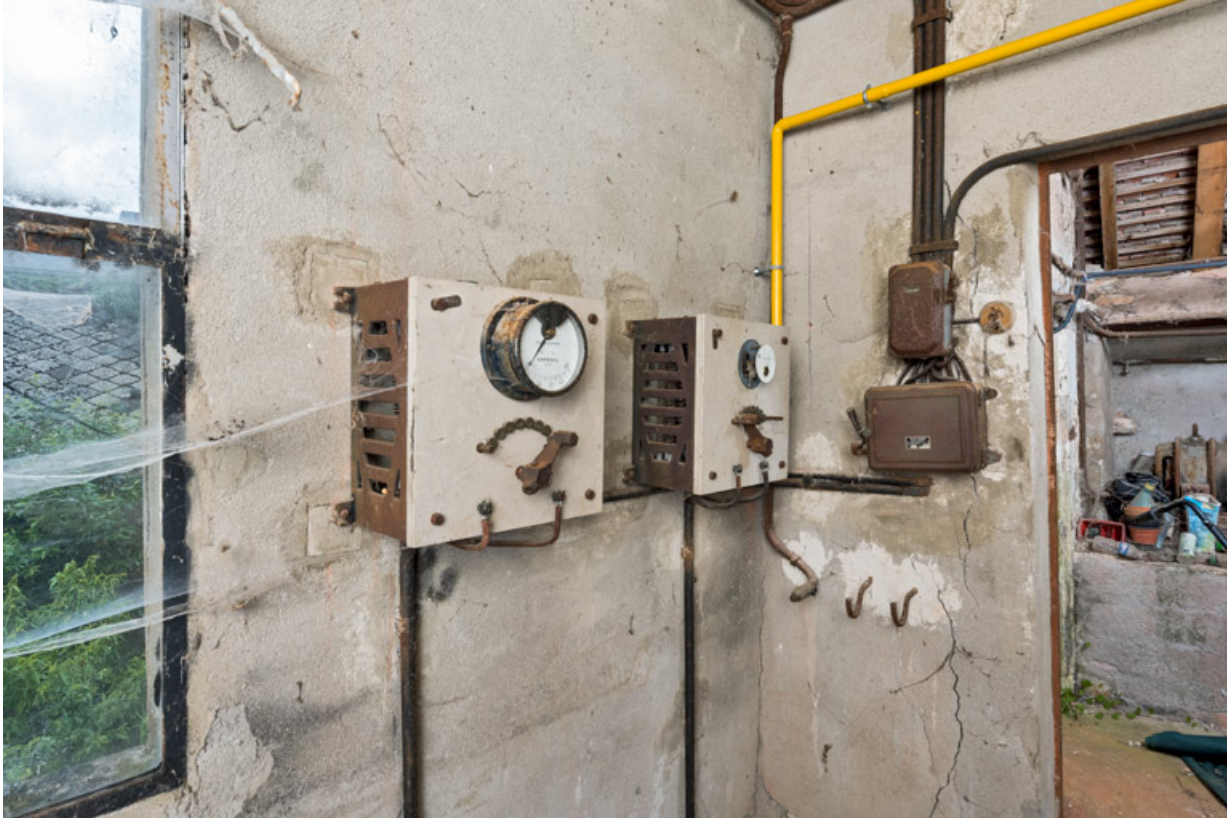
Cabine de projection : rhéostats.
