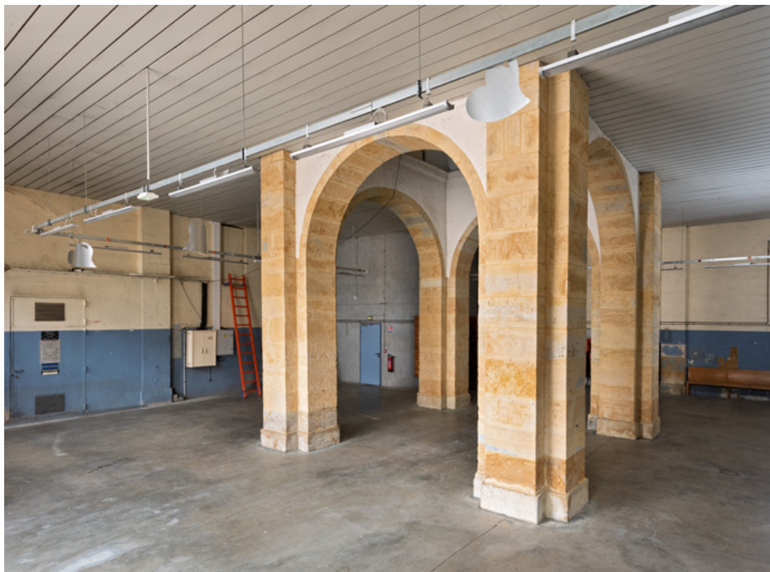
Rez-de-chaussée, halle : vue d'ensemble.
