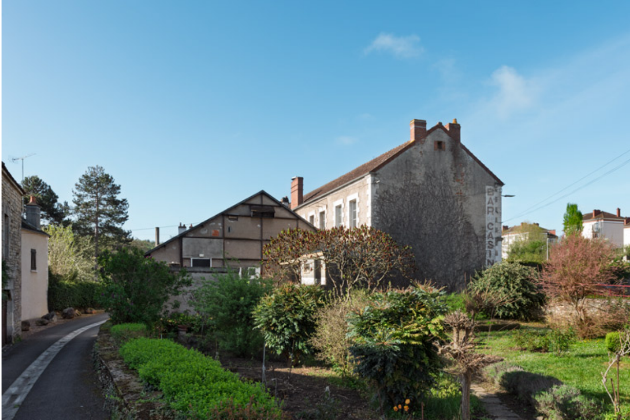
Façade postérieure et salle 1, depuis le nord-est.
