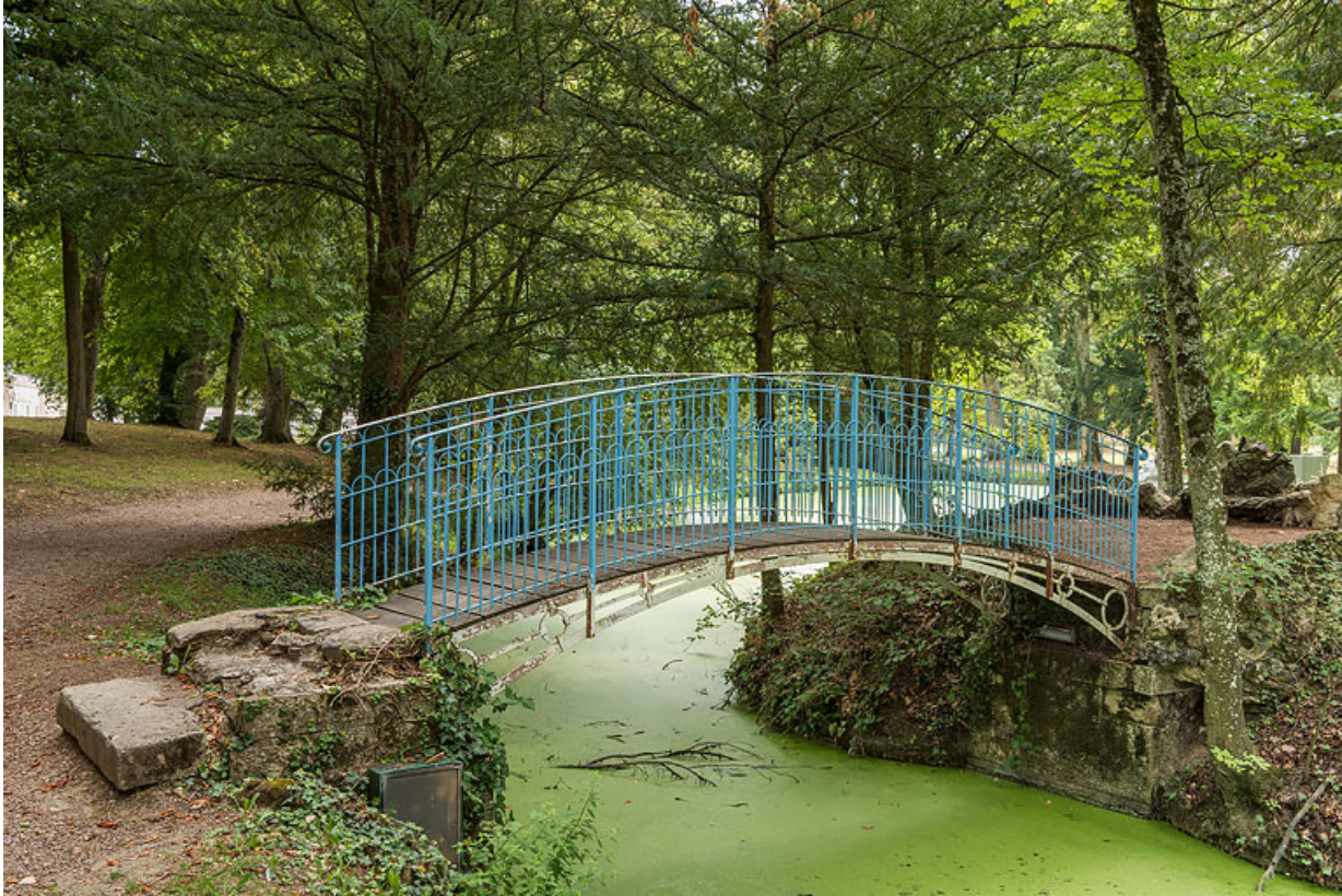
Passerelle métallique donnant accès à l'île.
